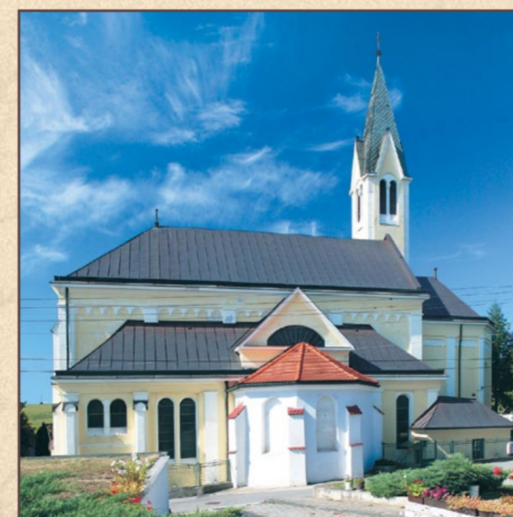
Kostol sv. Ladislava po rekonštrukcii strechy, 2009
