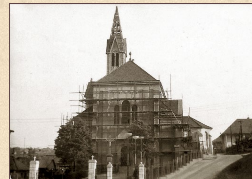
Výstavba oplotenia, rekonštrukcia veže a fasády, 1971 - 1974
